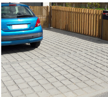
Dallage préfabriqué avec joints engazonnés ou gravillonnés
