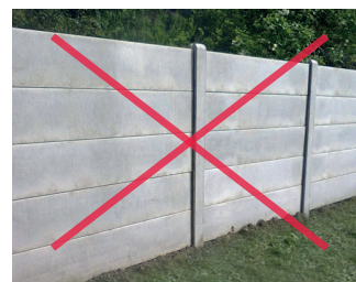
Clôture en plaques de béton
