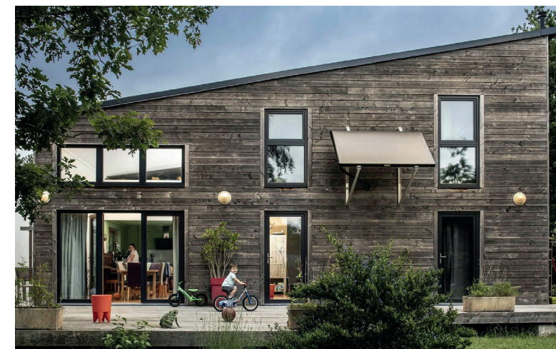
Source : Maison passive en bois réalisée par Autrement Bois Construction
