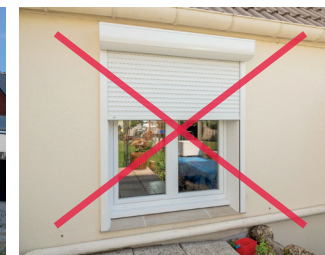
Caisson du volet roulant en applique sur la façade
