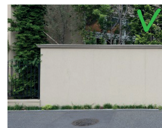
Mur maçonné, enduit deux faces avec couvertine
