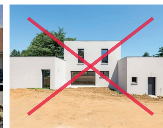
Toits terrasse sur l'ensemble des volumes
