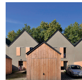
Garage traité comme une construction annexe
