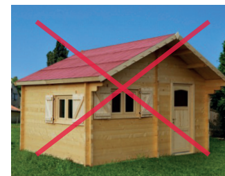
Toiture en revêtement bitumé + architecture trop chargée
