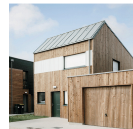
Garage accolé à la construction principale
