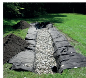
Tranchée d'infiltration
