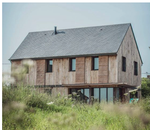
Source : Maison passive en bois réalisée en 2007 par «AnHeol architectes»
