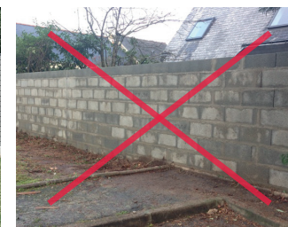
Mur maçonné non enduit
