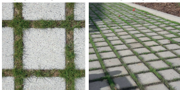
Pavés joints engazonnés
