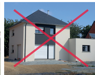
Toiture pointe diamant
