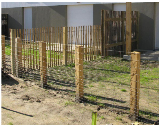
Clôture donnant sur le domaine public Poteaux bois section carrée + grillage acier galvanisé noué
