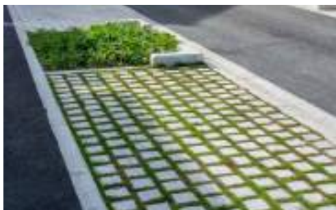
Pavés à joints enherbés
