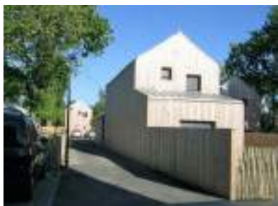
Mur pare-vue en harmonie avec le projet de la maison (même matériau, continuité)
