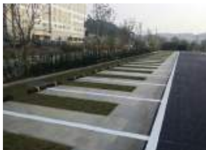
Bande de roulement en béton avec engazonnement au centre
